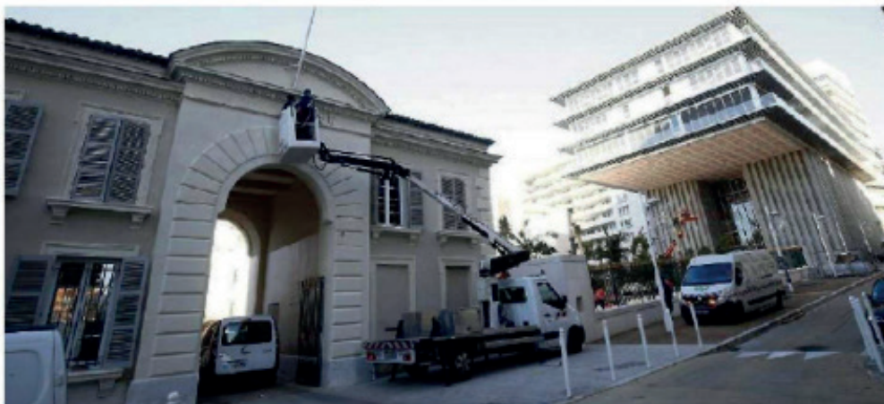
Dernières finitions sur le site de Chalucet avant le grand jour de l'inauguration, vendredi prochain
